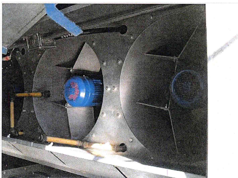
Рисунок 3 – Электродвигатель вентилятора подачи агента сушки после замены.
