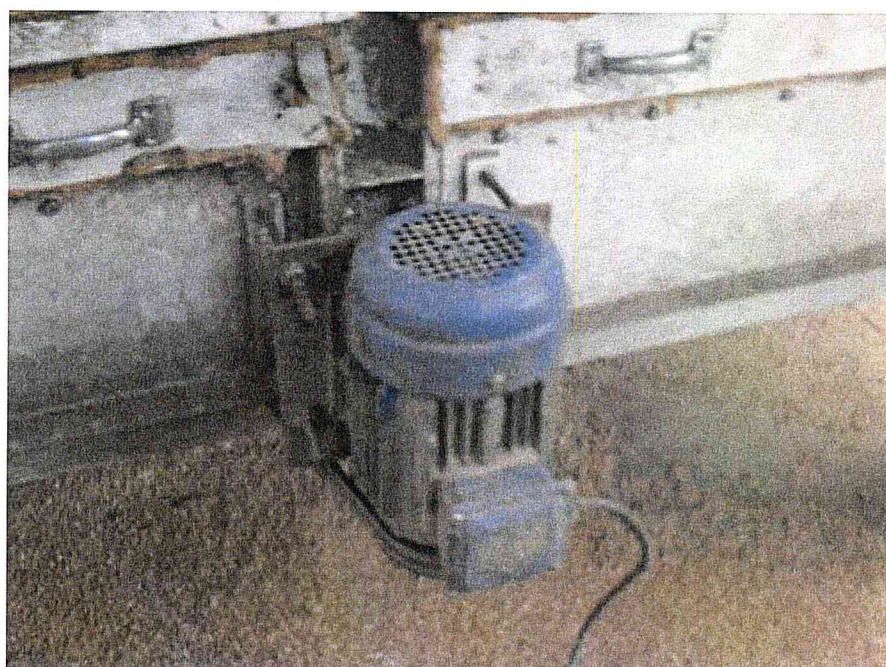
Рисунок 3 – Электродвигатель привода решетного кузова после замены.
