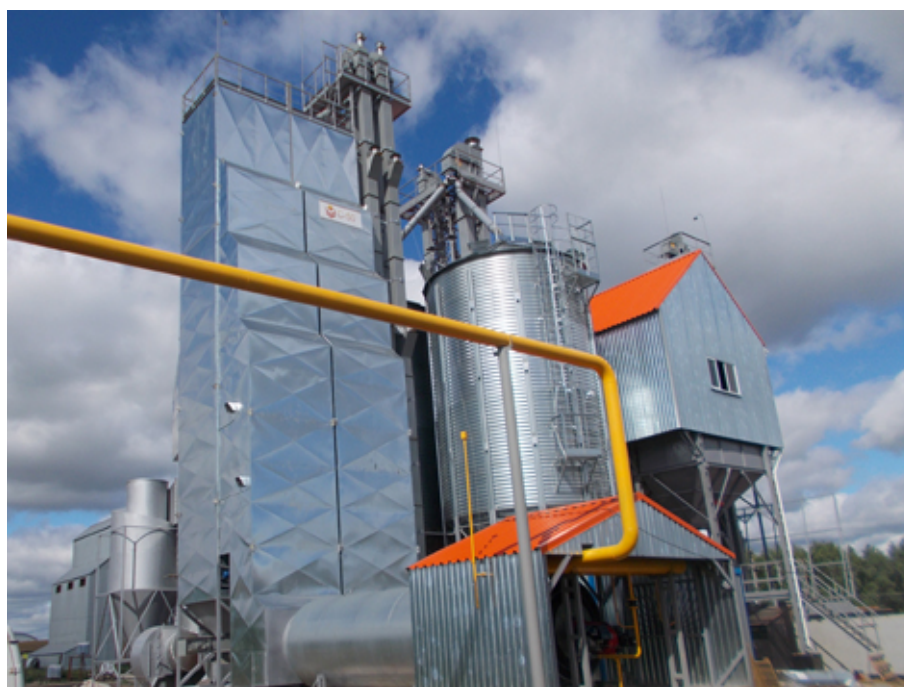
Рисунок 1 – Сушилка С-50 в составе зерноочистительно-сушильного комплекса.
